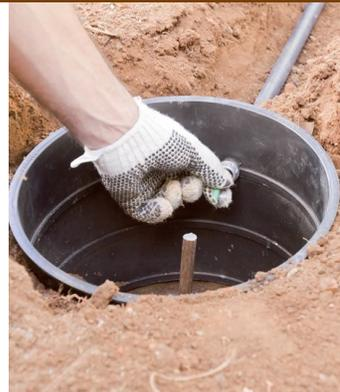
Agora é hora de conectar as pontas de prova do terrômetro nos três eletrodos, o eletrodo fixo (haste de aterramento, o eletrodo de potencial e o eletrodo de corrente, realizamos então a primeira medição.
